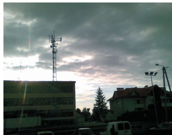
W Lisiej Górze stacje bazowe telefonii komórkowej zlokalizowane są w bezpośredniej bliskości domów jednorodzinnych, kościoła, ośrodka zdrowia i szkoły.
