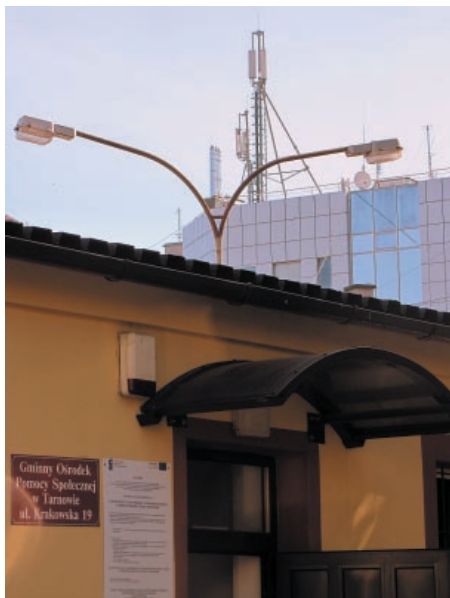
Taki widok na stację bazową telefonii komórkowej zlokalizowaną na Krakusie mamy z parkingu Urzędu Gminy Tarnów.
